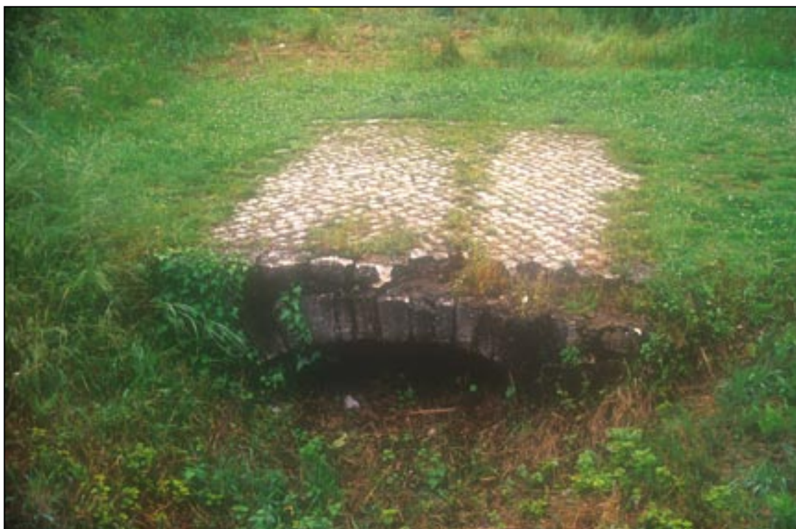
Il ponte medioevale della Catena (foto G. Mecchia)
