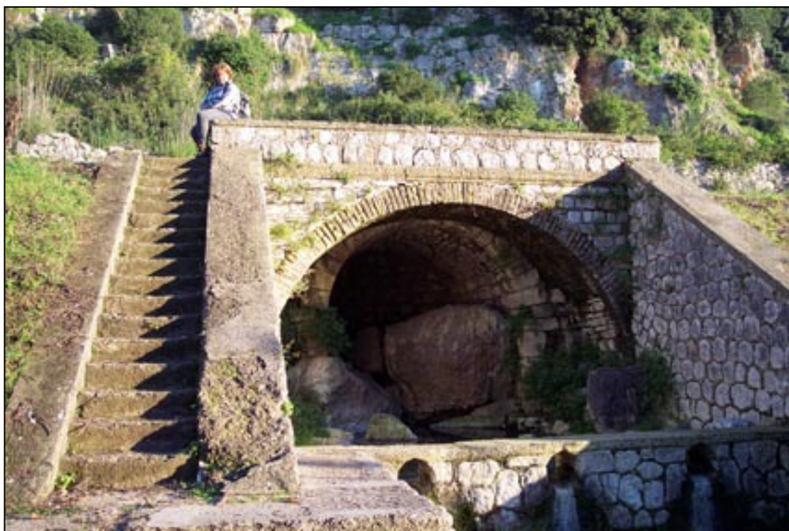
La sorgente di troppo pieno pochi metri a monte della Sorgente di Fiume Coperto, che si trova a circa 100 m dall'ingresso della grotta omonima; all'interno si nota l'opera muraria di probabile epoca romana inglobata nelle opere di sostegno della strada degli inizi del XX secolo (foto G. Mecchia)
