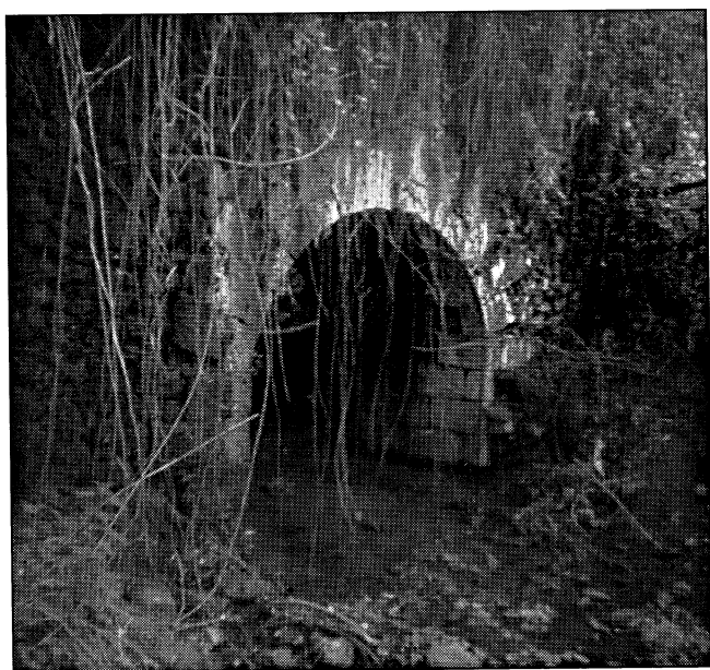
Arcata dell'acquedotto Traiano (Foto G. Pintus)
